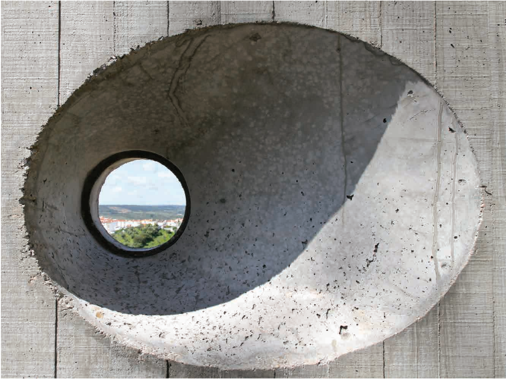
Detalle en obra del óculo construido con el molde fabricado en ARX para el Mercado Municipal de Abrantes (actualmente en construcción). Fotografía: ARX.
