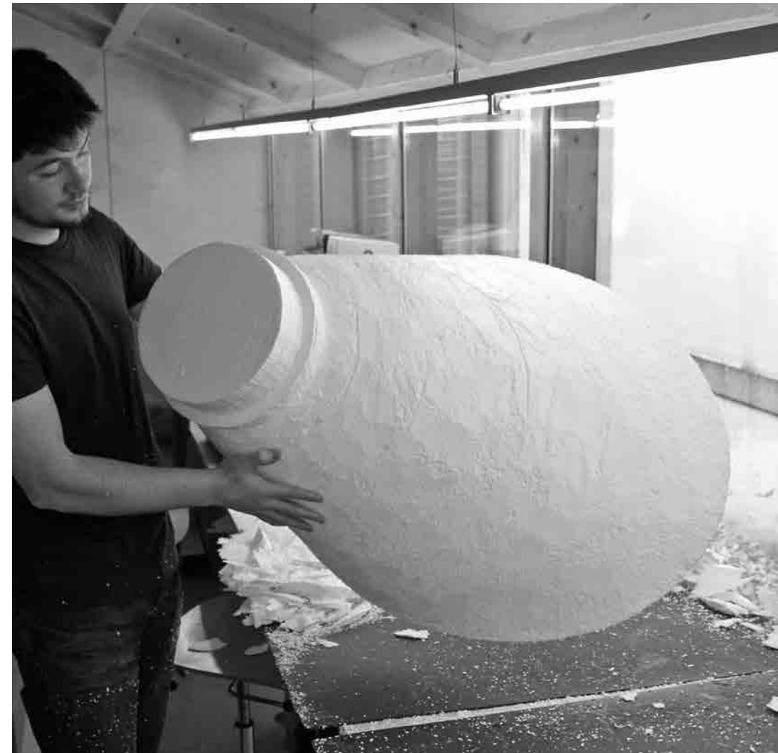
Ejecución de ARX de molde para los encofrados de concreto armado (óculo en el piso 1). Fotografía: ARX.
