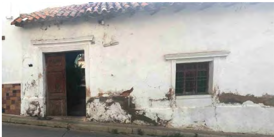
Fachada de la casa del Cristo de la Tres Caídas
